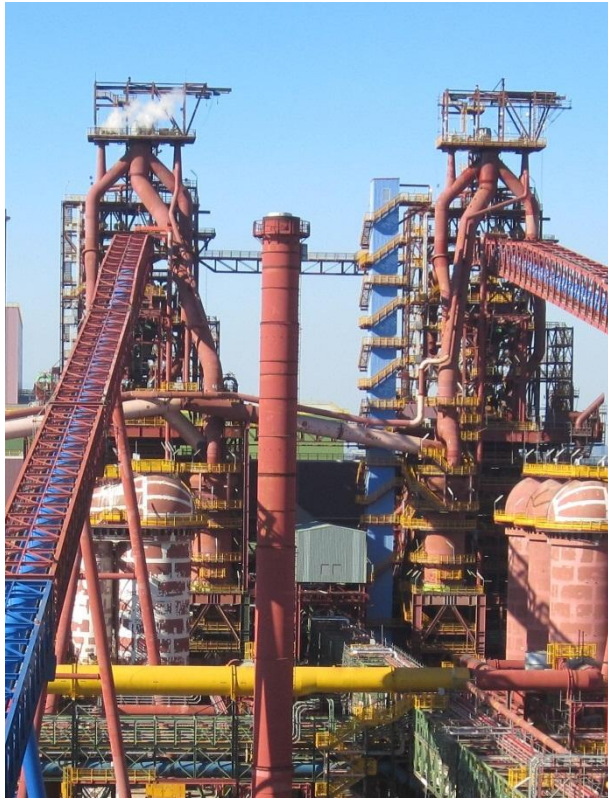
New BF1 & BF2, ThyssenKrupp CSA, Brazil
